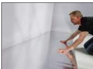
Verlegeunterlage auf vorbereitetem Untergrund auslegen.
