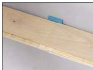
Mit Hilfe von den Kunststoff-Rastkeilen zu allen Wänden und festen Objekten im Raum einen Abstand von mindestens 10 bis 15 mm einhalten.
