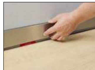
Randfugen mit passenden Sockelleisten aus dem umfangreichen Parador Sortiment abdecken.
