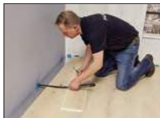
Mit Hilfe eines Reststücks oder des Parador MultiTools wird der Wandverlauf auf die letzte Dielenreihe übertragen.
